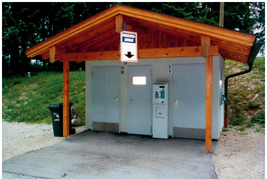
Rollstuhlgeeignete Toilette am Göllhäusl/Hinterbrand
