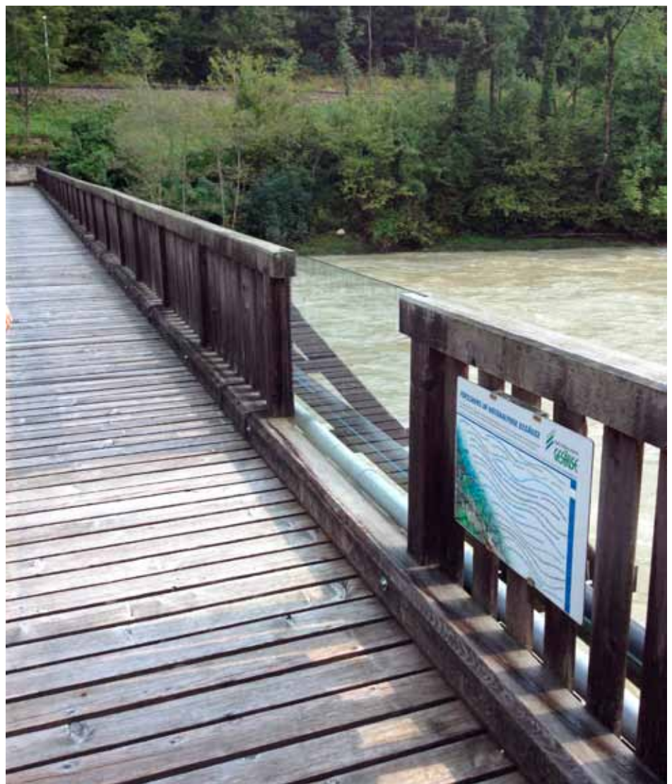
Brücke über die Enns im Nationalpark Gesäuse mit Durchguck im Geländer auf Höhe von Rollstühlen Bridge over the Enns in Gesäuse National Park with a view through the railing at wheelchair height
